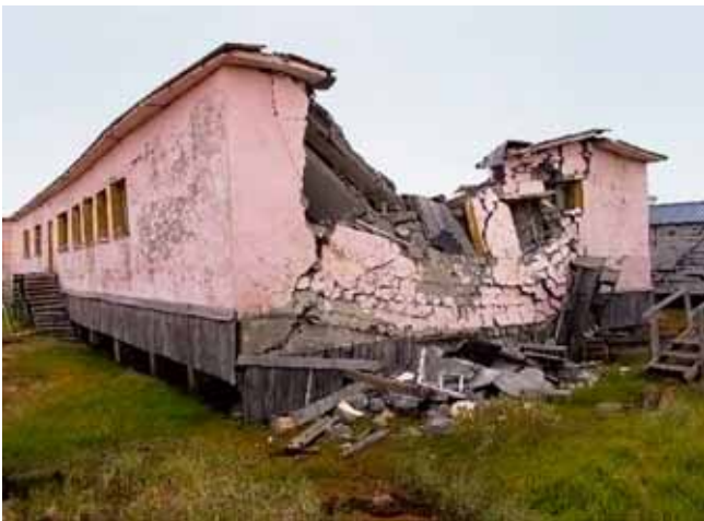
Рис. 8. Деформации зданий в п. Амдерма в 2021 г.: слева — жилой дом, справа — здание почтового отделения
