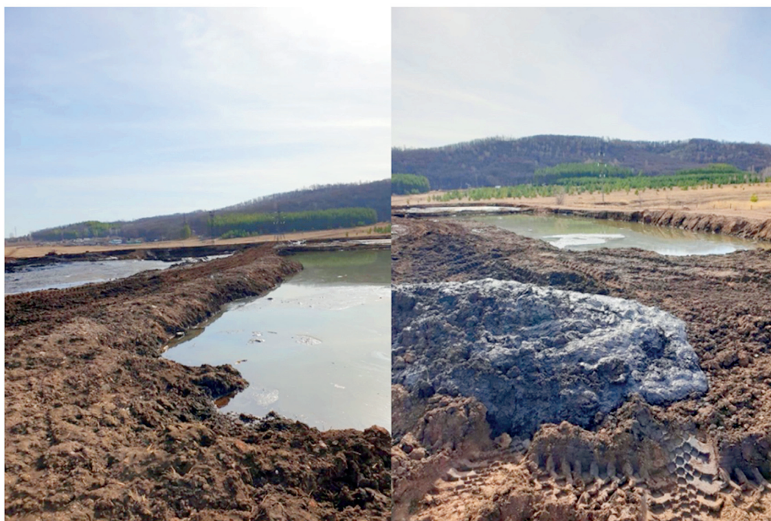
Рис. 1. Открытый нефтешламовый амбар на территории одного из месторождений Татарской НГО
