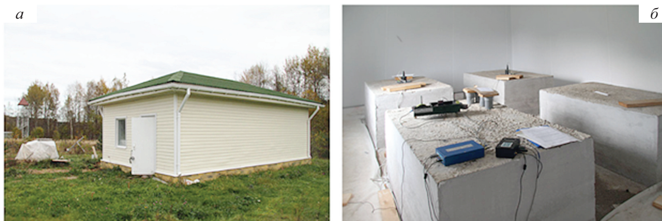
Рис. 1. Место установки сейсмической станции: а — немагнитный павильон, б — постаменты для установки оборудования
