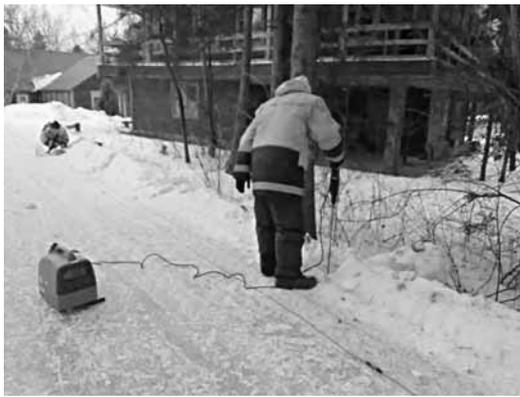
Рис. 8. Бурение отверстий под электроды
