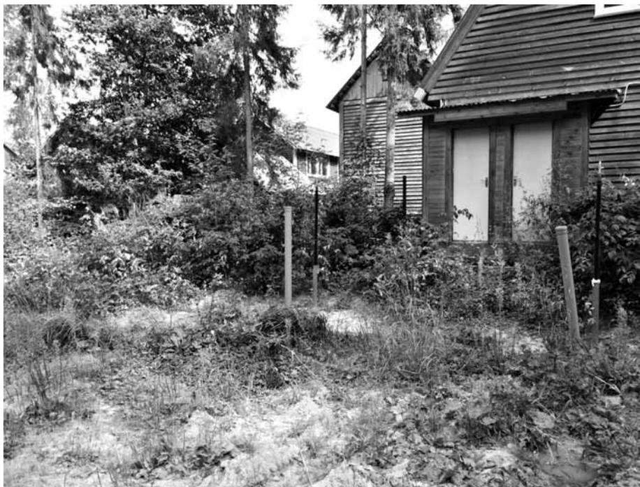
Рис. 17. 10-метровые СОУ вертикального типа естественной циркуляции с температурными скважинами
