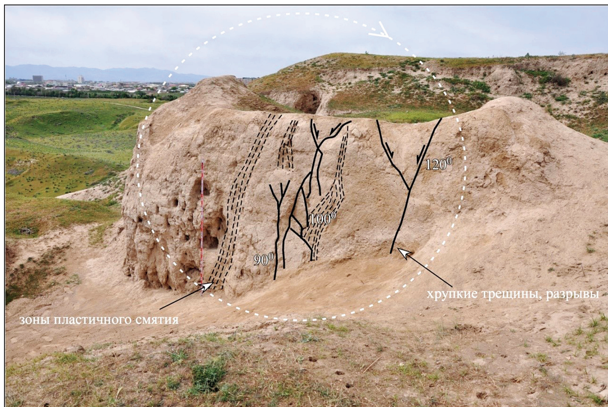
Рис. 7. Перпендикулярная стена (объект 2 на рис. 1). Остатки стены IX–X вв., пристроенной к южной стене донжона, имеют хрупкие (жирные сплошные линии) и пластичные (штриховые линии) деформации. Следы землетрясения X в. Возможно, что вся эта стена постепенно развернулась по часовой стрелке: круг показан штриховой линией. Длина измерительной ленты 2 м. Фотография 2023 г. Вид на юго-запад
