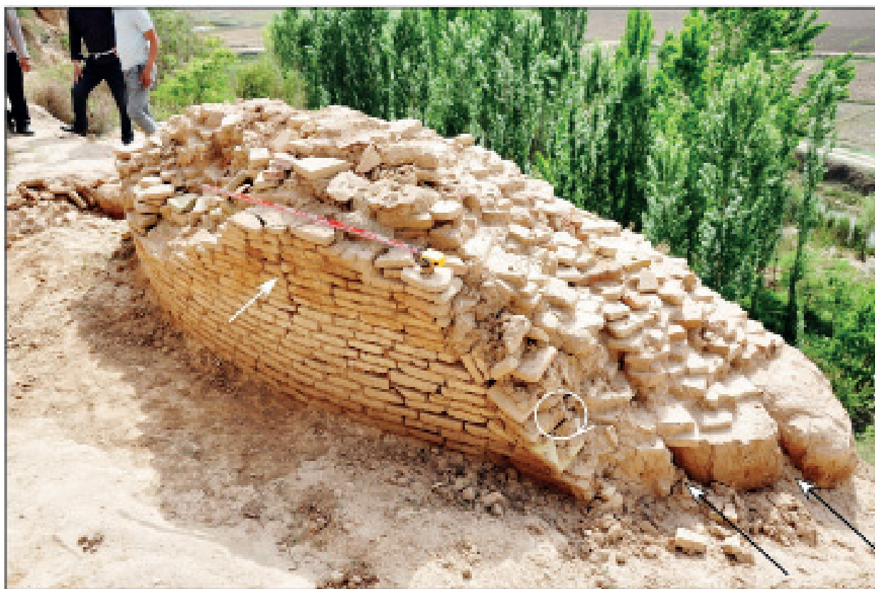
Рис. 4. Остатки круглого минарета, сложенного из обожженного кирпича. Южная часть строительного сооружения срезана эрозийной деятельностью р. Сырдарья. Черные стрелки — разрывы грунта, также рвущие кирпичную кладку. Белая стрелка — трещина, раскрывающаяся кверху. Окружность со стрелками показывает поворот кирпичей по часовой стрелке в месте выпадения западной части стены минарета наружу
