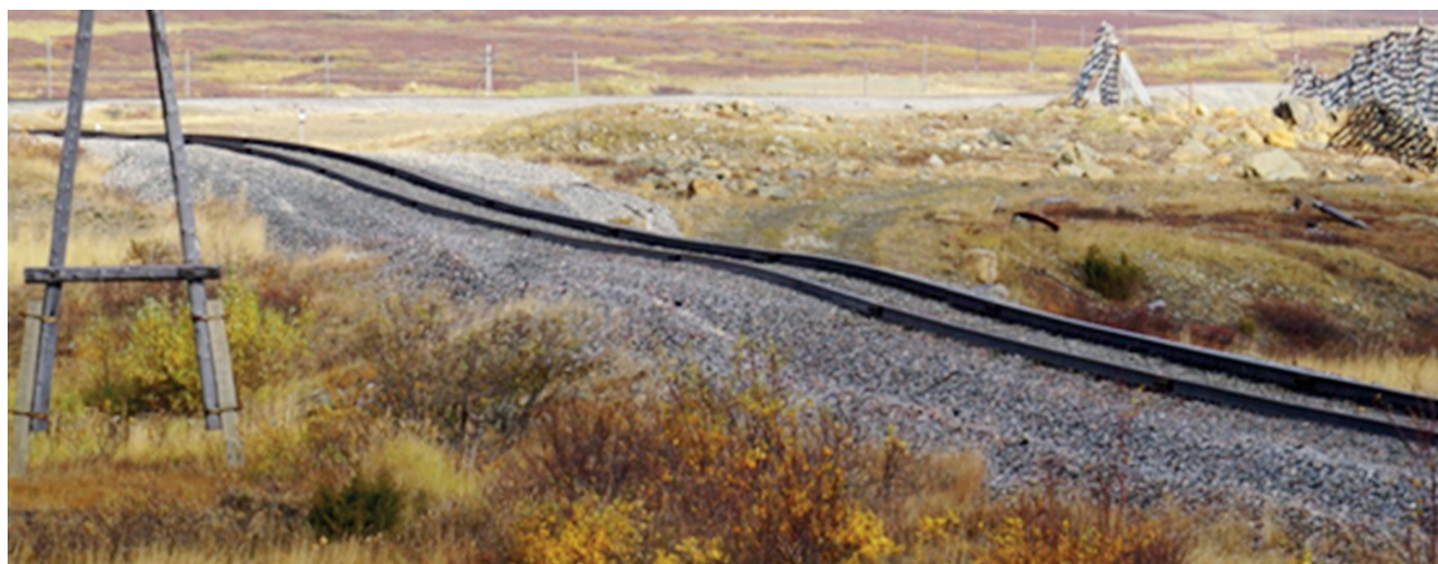
Рис. 1. Характерные просадки пути в районе исследований
