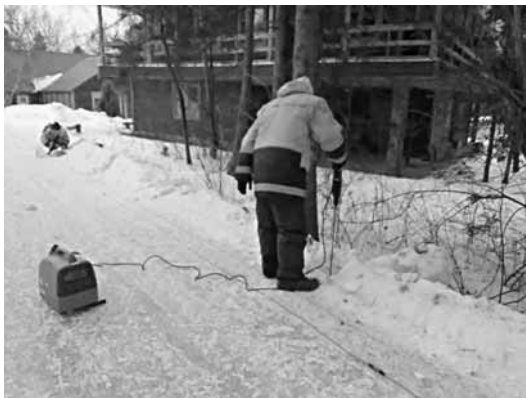
Рис. 8. Бурение отверстий под электроды
